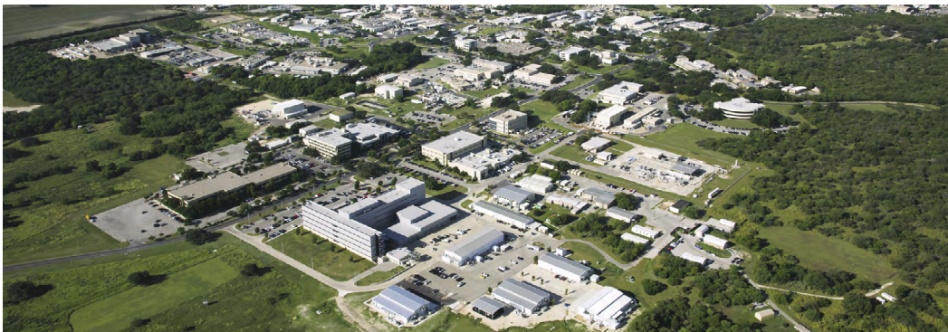
Le siège social du Southwest Research Institute à San Antonio au Texas comprend plus de 213 000 mètres carrés de laboratoires, d'installations de test et d'espaces de bureau.
